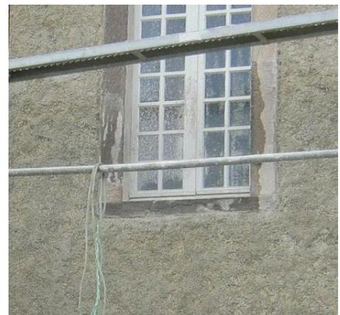
*OUI- enduit isolant remplaçant l'enduit existant*
