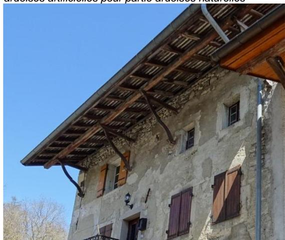
Passage de l'Atelier, lattis et voligeage apparent en sous-face
